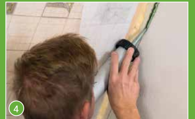
4 바닥 및 벽체와 만나는 부위에는 XtraFit를 먼저 도포한 후 XtraSafe 필름을 부착합니다.
