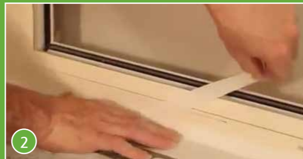
2 접착성을 높이기 위해 주변 먼지 및 이물질 제거 후 가장자리 15mm 스트랩 제거하여 창호프레임에 부착 합니다.
