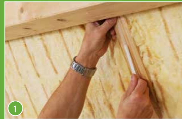
1 목재 스티드에 XtraFit를 부착합니다. (벨크로 시스템)
