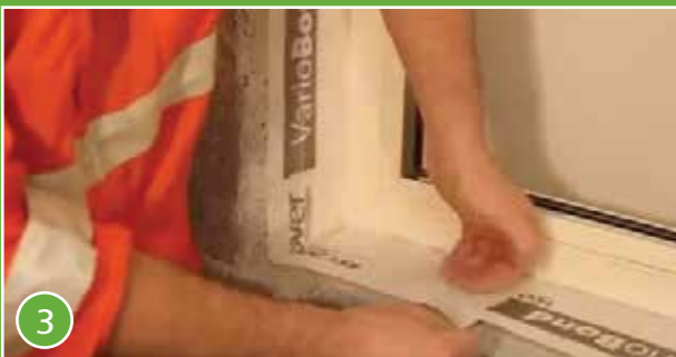
3 VARIO Bond 100의 경우 나머지 85mm 스트랩 제거하여 창틀에 부착합니다. VARIO Bond 150의 경우 100mm > 35mm 순서로 창틀에 부착합니다.
