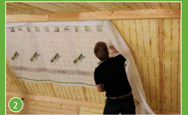
2 붙여둔 XtraFix위에 XtraSafe 필름을 부착합니다.
