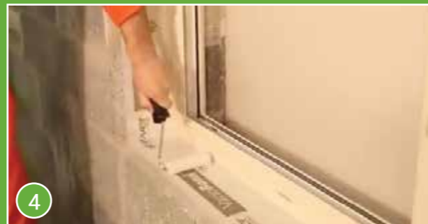
4 롤러로 Tape 부착면을 고르게 마감 합니다. 필요시 VARIO Bond 위에 미장도 가능 합니다.
