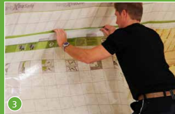
3 XtraTape를 필름 연결부위에 부착합니다. 이때 필름간 최소 10cm이상 겹쳐서 시공합니다.
